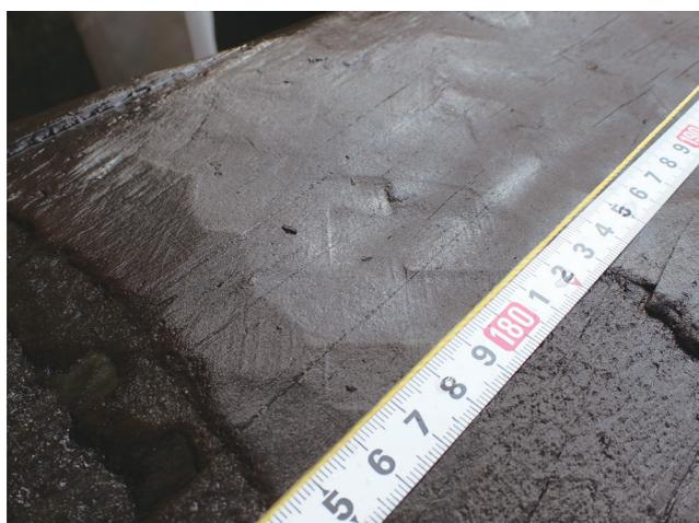
写真5 柱の表面に残る刃こぼれの痕跡 (写真中央)。
